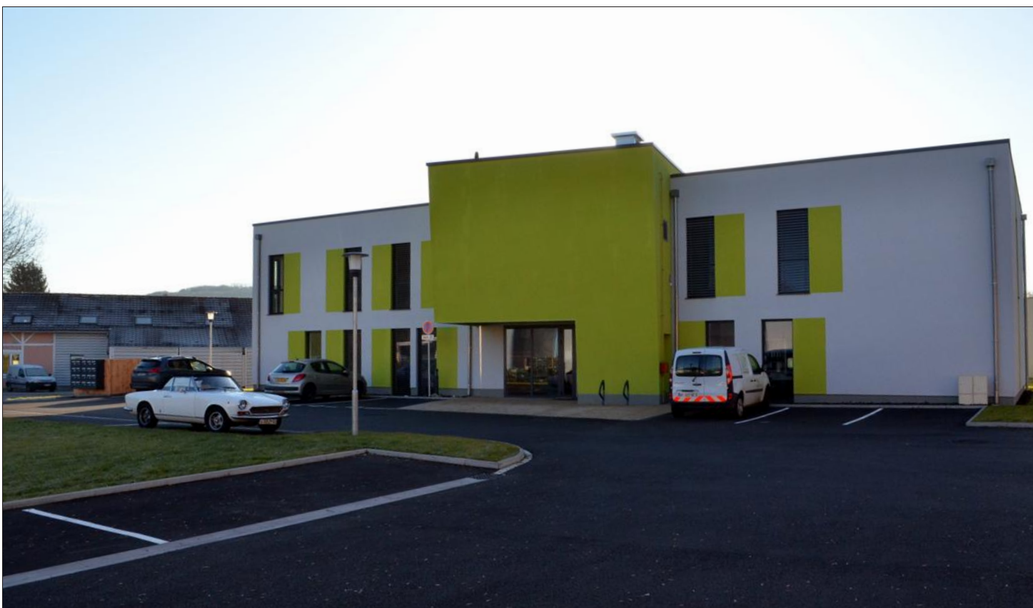
Le bâtiment BBC à ossature bois abritant les 14 bureaux a coûté 1,7 million d'euros. La CCSI a bénéficié de 850 000 € d'aides de l'État, de la Région et du Département.
